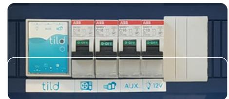
**Descrição técnica:** Disjuntores magnéticos térmicos controlados (2 x C16 e 1 x C10), disjuntor D16 para bomba de calor, transformador 230/12V 100VA, contactores x 220V, interruptor modular de 33 posições
