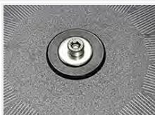
Insertar el tornillo Allen con la arandela M6 de ala ancha por la cara activa del panel del SUNIR-1a.
