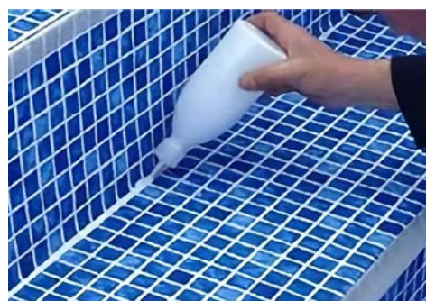
Sele cada costura soldada com selante de costura (PVC líquido).
